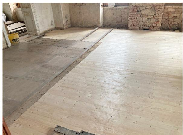
Erneuerung von drei Deckenbalken und Unterzug (Stahl), aufbringen der Unterdielung zweilagig
